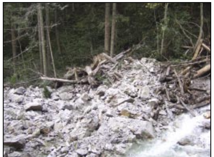
Felsen nach der Sprengung
