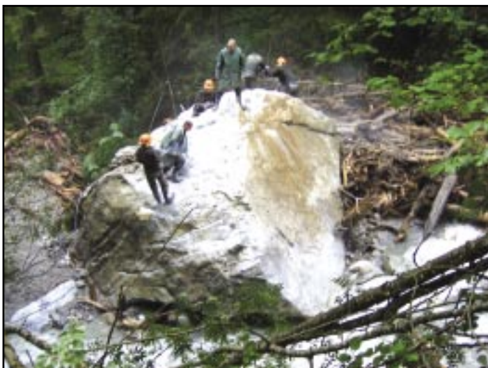
Felsen vor der Sprengung
